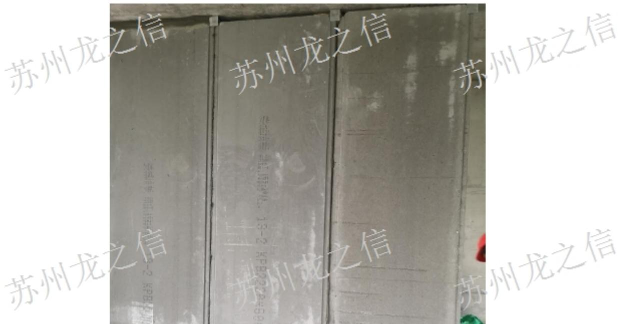
ALC轻质隔墙板也称蒸压加气轻质混凝土板，属于新型建筑节能产品。其具有容重轻、隔音保温效果好、造价低廉、安装工艺简单、工期要求较低、生产工业化、标准化、安装产业化等优点，目前在高层框架建筑以及工业厂房的内外墙体获得了很广的应用。
